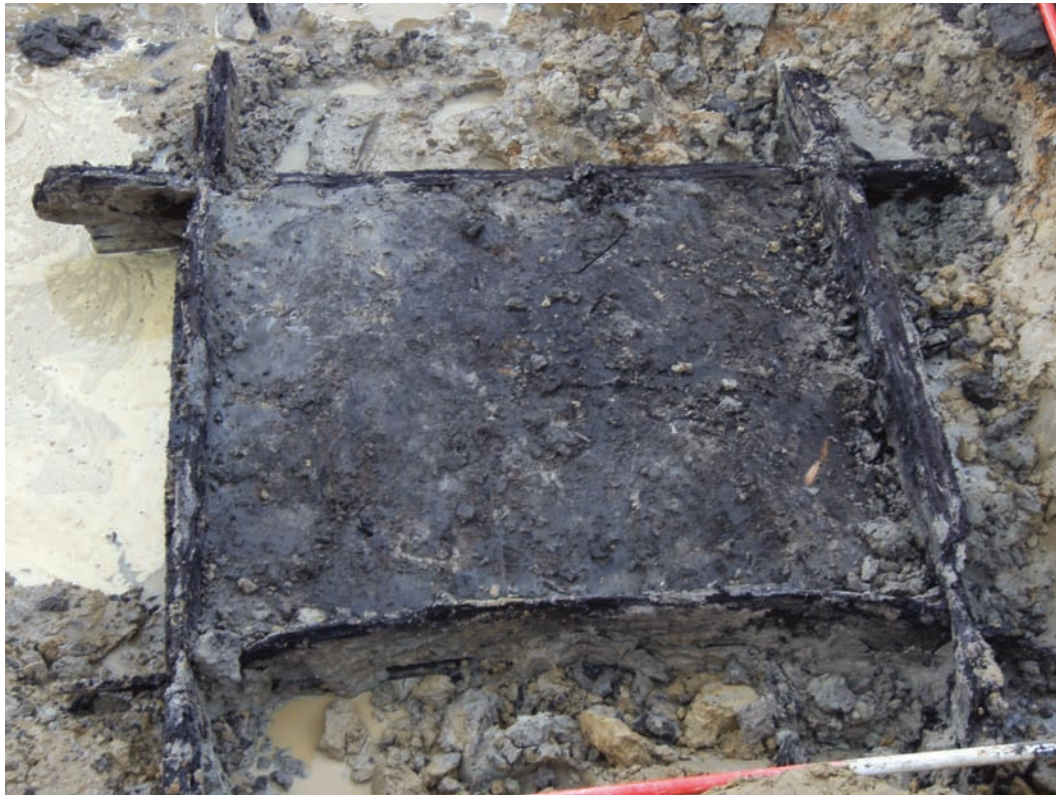
Afb. 10.3 De Romeinse waterput (DG2_WA01) tijdens het couperen.
