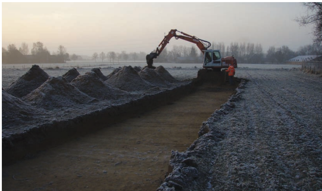
Afb. 2.2 Aanleggen van een proefsleuf.
